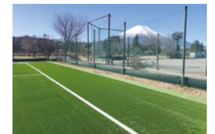
流出抑制システム導入の様子
