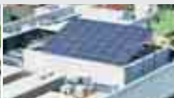
「屋上に設置された太陽光パネル」
