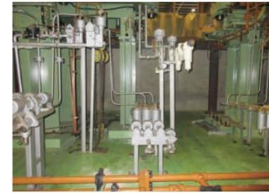
中国・湖南工場に設置した蒸気配管へのドレンポケット
