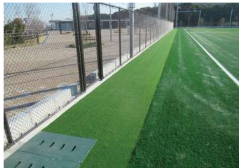
雨水溝上にフィルター材として透水性人工芝を設置するとともに外周をブロックで囲うことで風による飛散を抑制
